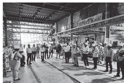
9/8 建設部会工事現場見学会
